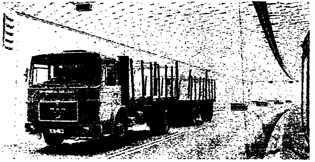
مخزل احد الممرات داخل النفق
